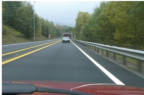
Figur 3. Forsøksstrekningen på E6 i Oppland, sett i sørgående retning, før og etter oppmerking av midtfelt.
