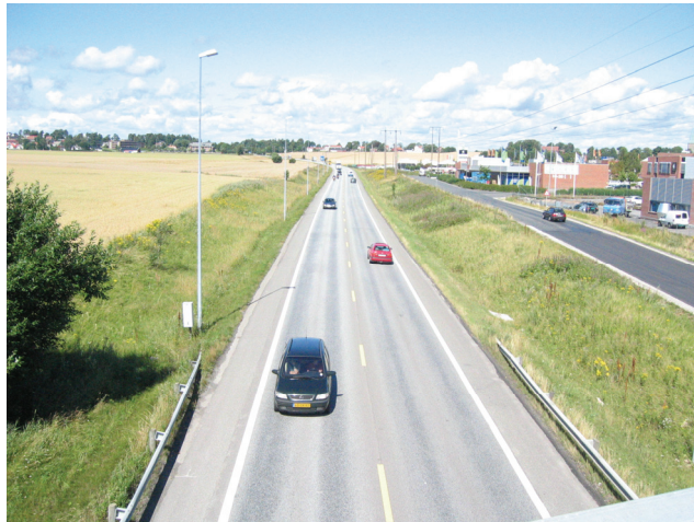
Figur V-2. Strekning for måling av sideplassering på veg med standard midtlinje. (E6 Østfold)
