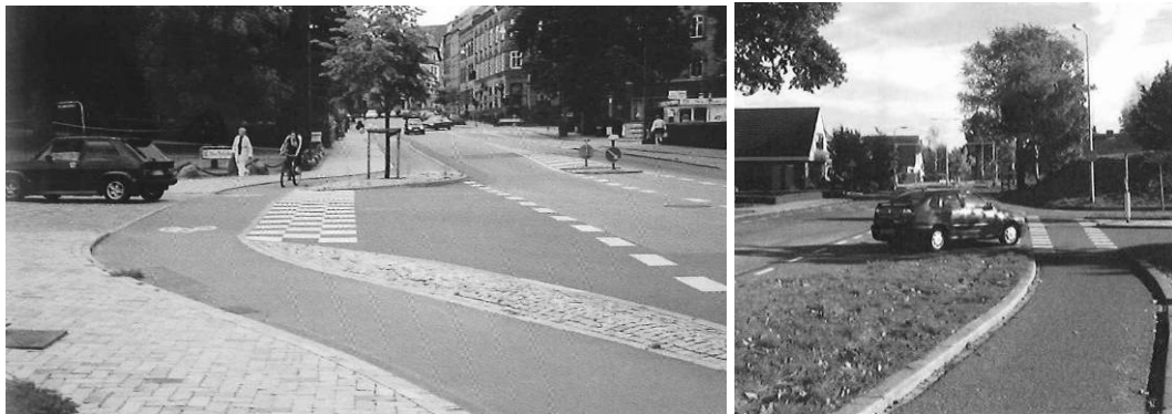
Figur 91. Eksempel på tilbaketrukket sykkelsti i Danmark og Holland (Vejdirektoratet 2000b, CROW 2007).
