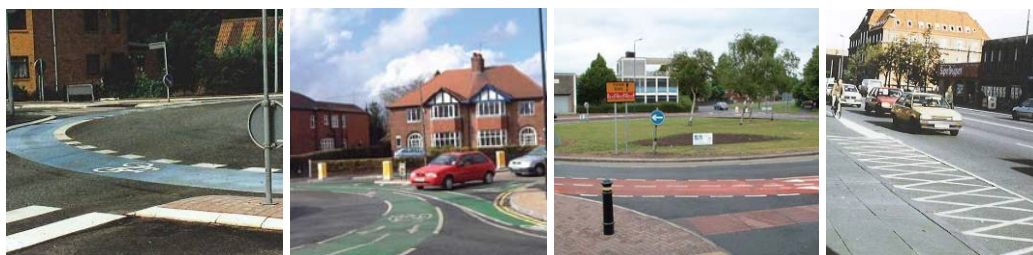
Figur 90. Farget belegning av sykkelfelt i rundkjøring i Danmark og England og harlekinmønster brukt i T-kryss i Danmark (Vejdirektoratet 2000b, NCC 2006).
