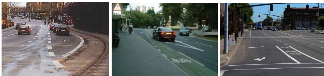
Figur 68. Eksempler på midtstilt sykkelfelt i Danmark, England og USA (Vejdirektoratet 2000b, NCC 2006, Drdul 2004).
