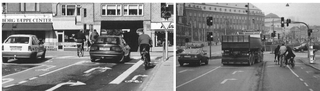
Figur 73. Eksempler på separat høyrestilt sykkelfelt og kanalisert høyrestilt sykkelfelt i Danmark (Vejdirektoratet 2000b).
