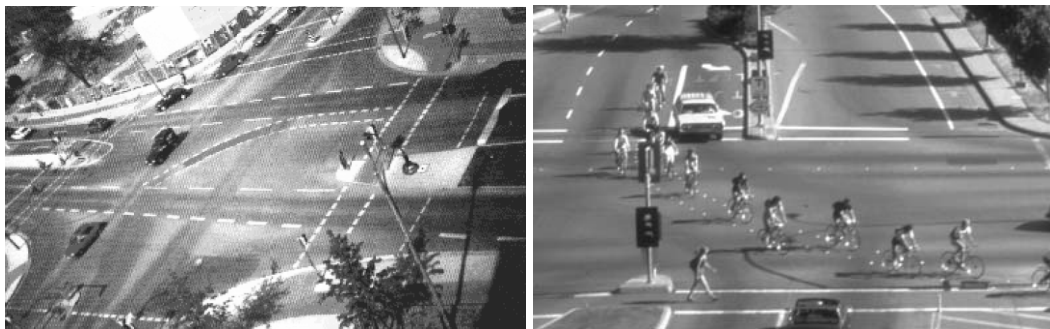
Figur 79. Eksempler på separat venstresvingsfelt for sykler i kryss i Tyskland og USA (Sachsen Anhalt 2003, Wisconsin Department Of Transportation 2004).
