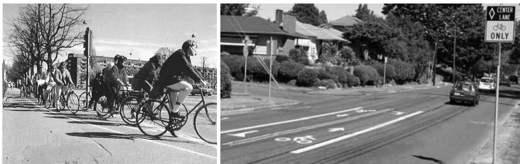
Figur 80. Eksempler på separat venstresvingsfelt for sykler i T- kryss i Danmark og Canada (Vejdirektoratet 2000b, Drdul 2004).
