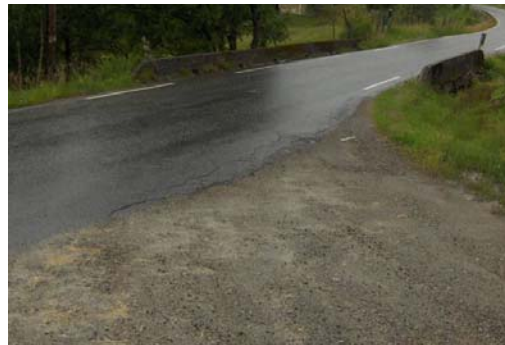
Figur 14. Eksempel på innkjørsel som kan brukes som møteplass (Sørensen og Hanssen 2008).
