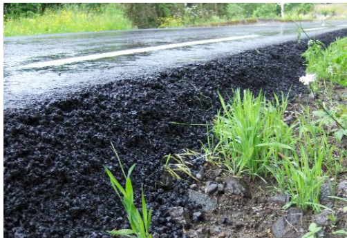
Figur 13. Høy kant mellom den asfalterte kjørebane og skulder/grøft (Sørensen og Hanssen 2008).
