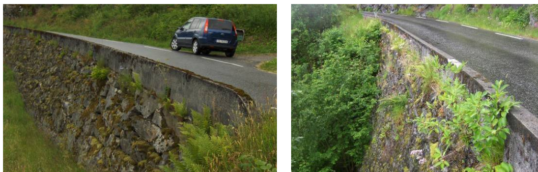
Figur 4. Eksempel på støttemurer (Sørensen og Hanssen 2008).
