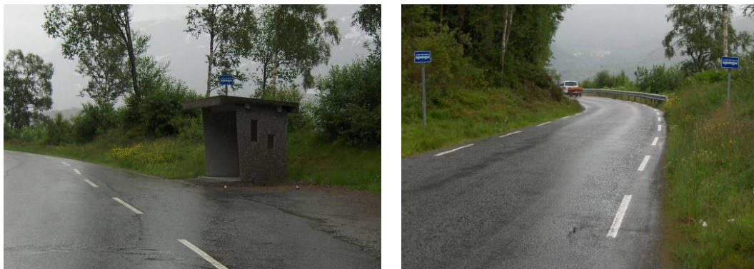
Figur 9. Eksempel på holdeplass med forbi kjøring mulighet og holdeplass uten slik mulighet (Sørensen og Hanssen 2008).
