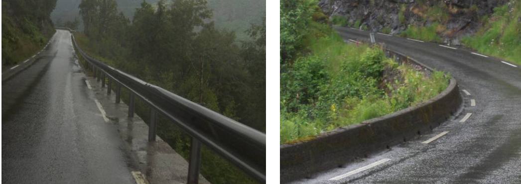
Figur 15. Eksempler på rekkverk - aluminium og støpt (Sørensen og Hanssen 2008).
