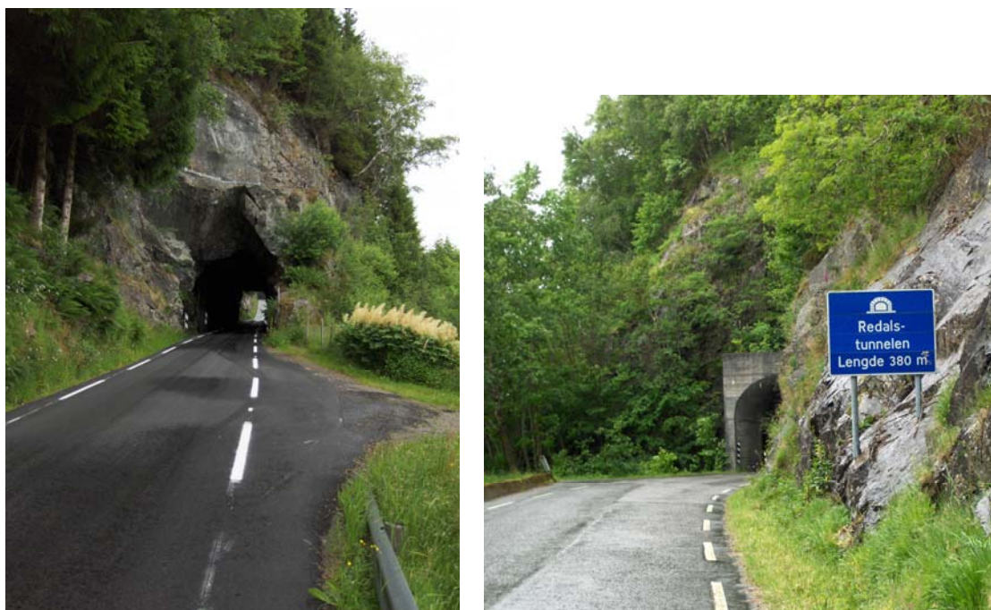
Figur 17. (a) Oversiktlig situasjon ved Frammarsviktunnelen og (b) uoversiktlig situasjon ved inngangen til Redalstunnelen (Sørensen og Hanssen 2008).
