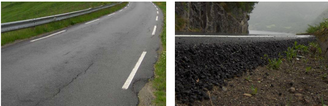
Figur 3. Eksempel på slitt vegdekke til venstre. Eksempel på høy kant etter asfaltering til høyre. (Sørensen og Hanssen 2008).
