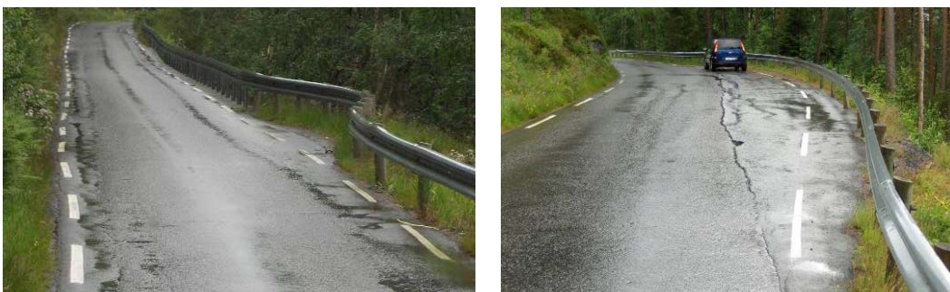
Figur 6. Eksempel på en liten "møteplass" og en større møteplass (vegutvidelse) som også gir plass til en buss eller en lang lastebil (Sørensen og Hanssen 2008).
