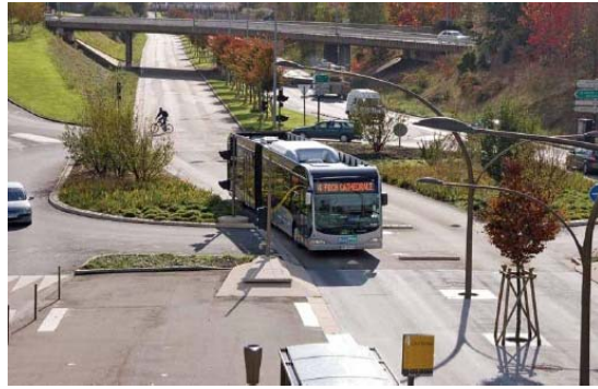
Buss gjennom rundkjøring. Kryssende biltrafikk stoppes med signaler styrt av bussen. Nantes 2008.
