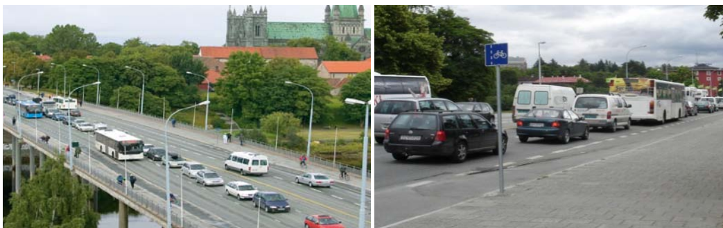
Figur 26. Bedre fremkommelighet for busser etter gjennomføring av gjennomgående kollektivfelt (Simonsen, 2009).
