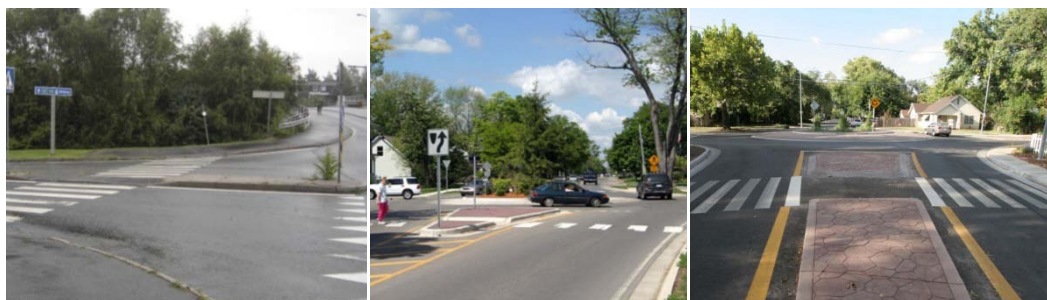
Figur 10. Eksempel på trafikkøy i gangfelt i Oslo (Foto: M. Mosslemi), i Michigan og i California (PBIC, 2010).
