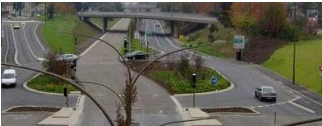
Figur 24. Bussen BusWay har full prioritet i alle kryss og rundkjøringer i Nantes, Frankrike (Foto: T. Loftsgarden).
