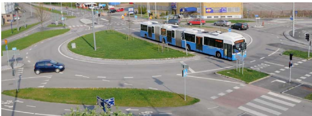
Figur 44. Busstrase i Norra Älvstranden, Göteborg, der bussen har prioritering gjennom rundkjøring (Andersson, Gibrand og Kottenhoff, 2009).
