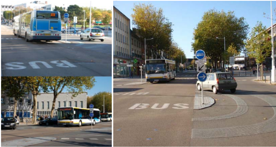
Figur 42. Bussen har forkjørsrett gjennom ovale rundkjøringer i Lorient, Frankrike (Foto: T. Loftsgarden).
