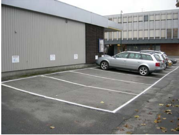
Figur 19. Parkering for kunder eller ansatte? Slike parkeringstilbud bidrar ikke til et attraktivt sentrum og gir mange avkjørsler over fortauet. Slike ordninger er ikke ønsket fra vegmyndighetens side.
