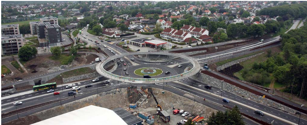
Figur 61. Sykkelrundkjøring i Tjensvollkrysset (Statens vegvesen, 2012a).
