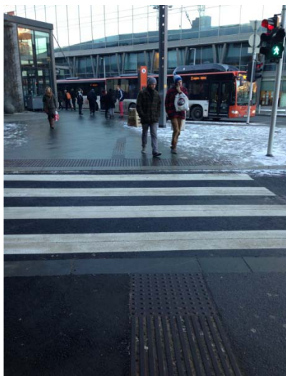
Figur 26: Bildet til venstre viser en fotgjengerovergang med ulike løsninger på hver side av gaten og hvor ulikheten i utforming skyldes at de er bygget som del av to ulike prosjekter på to ulike tidspunkt. Foto til høyre viser ledelinjer ført sammen i et uoversiktlig kryss og lagt på måter som ikke er i tråd med dagens håndbøker, mv. Forklaringer er at de ble bygget før dagens håndbøker, mv. ble tatt i bruk (begge foto: Ida Stenbråten Harildstad og Ingrid Ørsteng).
