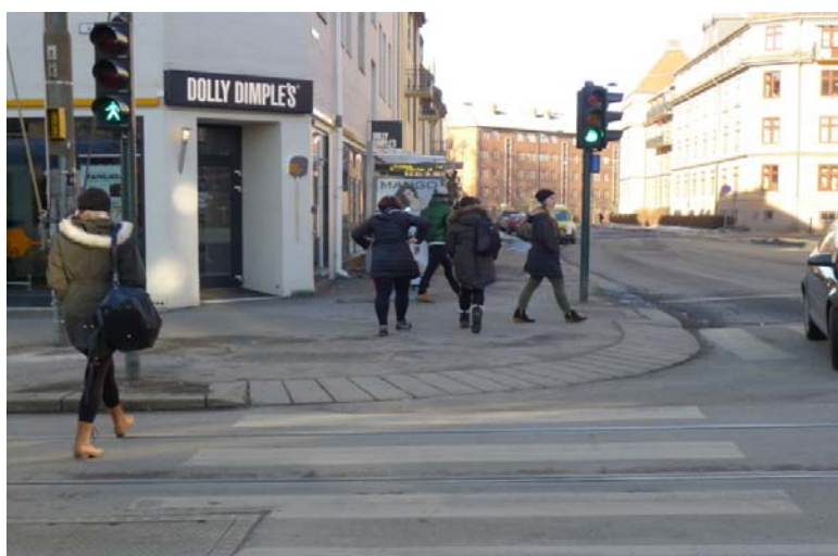
Figur 16: Nybygget fotgjengerkryssing i Vogts gate Oslo, hvor hele nedsenket ligger i bue og det mangler varselfelt (foto: Aud Tennøy).
