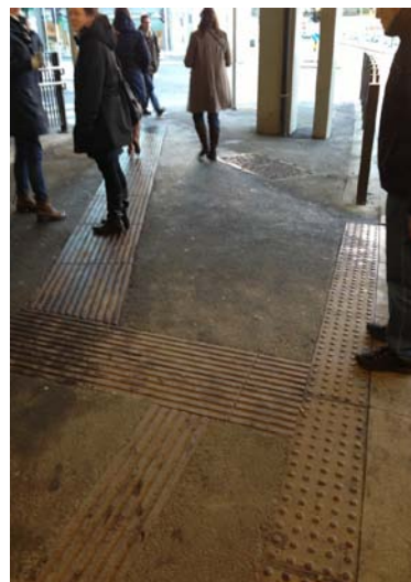
Figur 26: Bildet til venstre viser en fotgjengerovergang med ulike løsninger på hver side av gaten og hvor ulikheten i utforming skyldes at de er bygget som del av to ulike prosjekter på to ulike tidspunkt. Foto til høyre viser ledelinjer ført sammen i et uoversiktlig kryss og lagt på måter som ikke er i tråd med dagens håndbøker, mv. Forklaringer er at de ble bygget før dagens håndbøker, mv. ble tatt i bruk (begge foto: Ida Stenbråten Harildstad og Ingrid Ørsteng).
