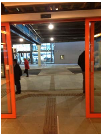
Figur 25: Det kan være vanskelig å avgjøre om og hvordan karusellører og dører med fotoceller skal markeres. Merk at varselsfeltet på utsiden av døren i bildet til venstre varsler trapp ned til gatenivå, og ikke døren (begge foto: Ida Stenbråten Harildstad og Ingrid Øvsteng).
