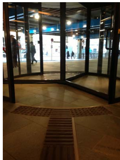
Figur 25: Det kan være vanskelig å avgjøre om og hvordan karusellører og dører med fotoceller skal markeres. Merk at varselsfeltet på utsiden av døren i bildet til venstre varsler trapp ned til gatenivå, og ikke døren (begge foto: Ida Stenbråten Harildstad og Ingrid Øvsteng).
