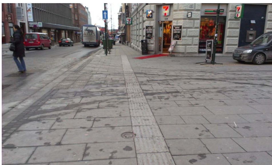
Figur 10: Er dette en unødvendig ledelinje? Ledelinjen krysser søndre del av Karl Johans gate i Oslo, like ved Oslo S (Foto: Aud Tennøy).
