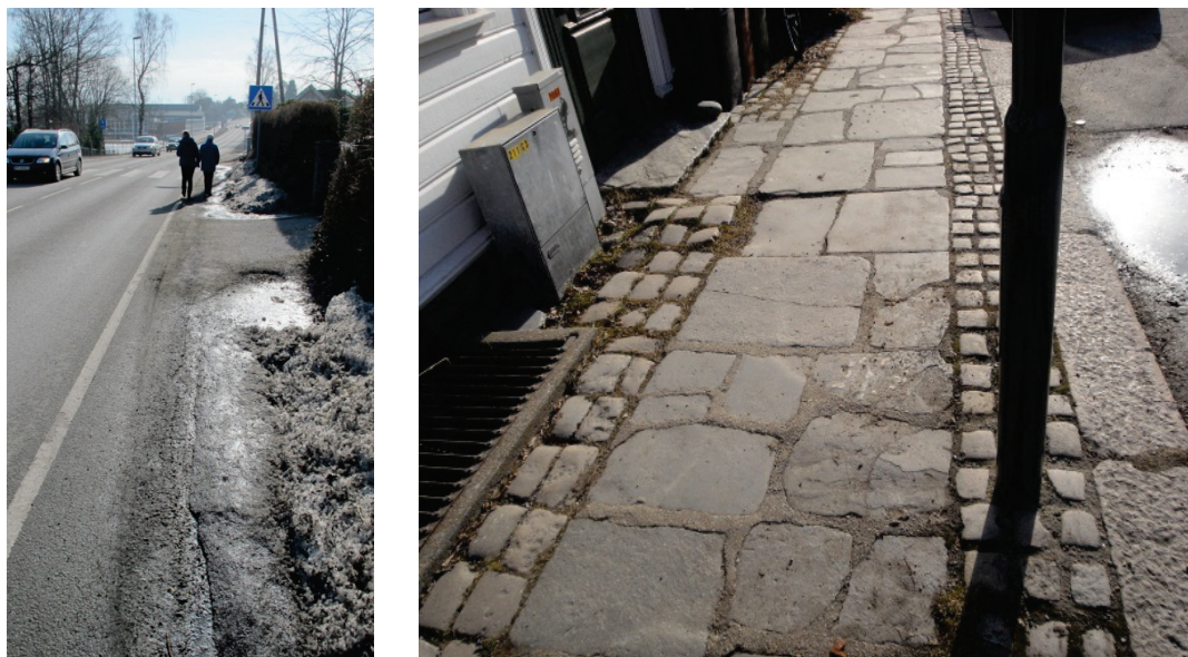
Figur 4.8: Manglende fortau på Voie til venstre, eksempel på fortau som er trangt og har vanskelig underlag for dem med rullestol eller rullator til høyre.
