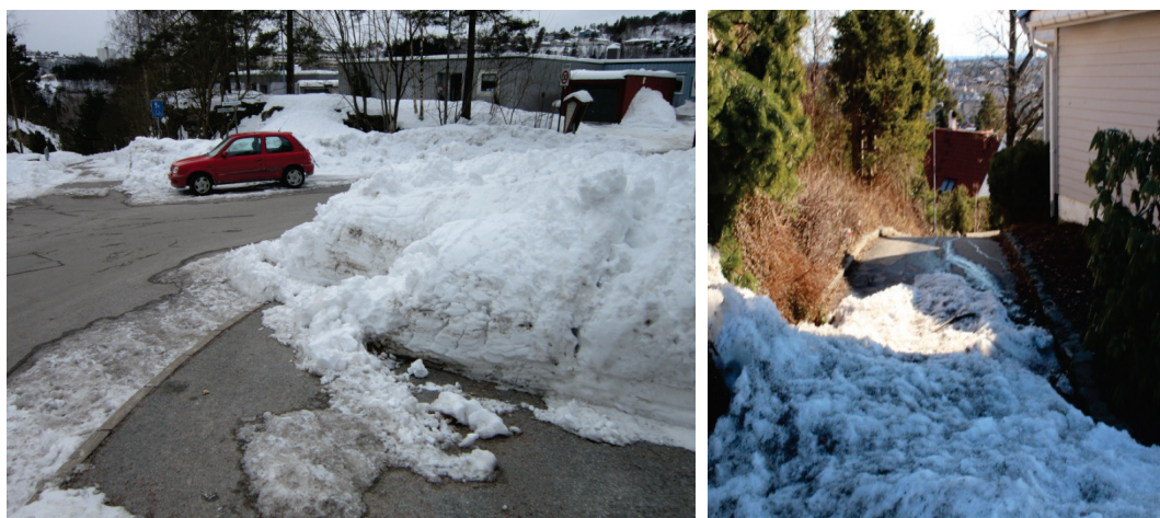
Figur 4.13: Til venstre ser vi at snøopplag gjør krysset uoversiktlig og presser fotgjengerne ut i veien. På bildet til venstre ser vi at brøytesnø sperrer en gangsti.
