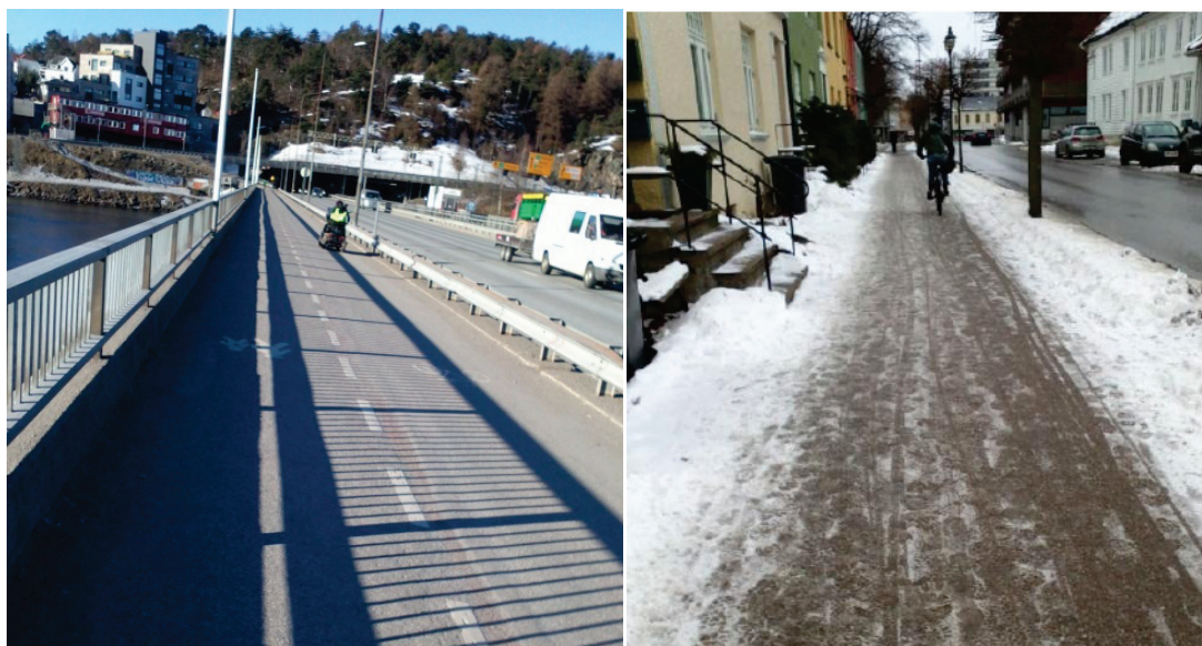
Figur 4.7: Til venstre ser vi Oddernesbrua, som ble fremhevet som et godt eksempel. Gående og syklende er separert og det er god plass. Til høyre ser vi en del av Elvegata med gang- og sykkelsti i ett. Det oppleves som en dårlig løsning.
