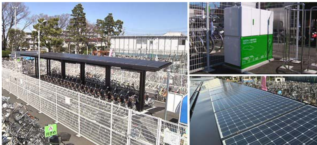
Figur 66: Solcelledrevet Sanyo ladestasjon i Tokyo, beliggende ved jernbanestasjon.
