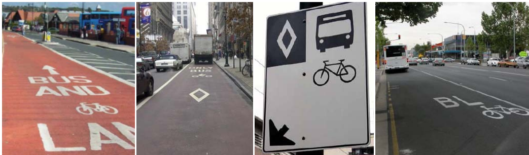
Figur 21. Eksempler på utforming, oppmerking og skilting av kollektivfelt med sykling i henholdsvis England, USA, Canada og Australia (Cycling England 2013, Boyle 2013, Drdul 2004, Austroads 2005).
