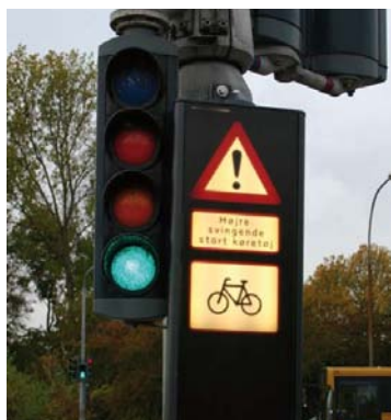
Figur 34. Variabel tavle som varsler de syklende når det er et tungt kjøretøy (Olsen og Bloksgaard 2009).
