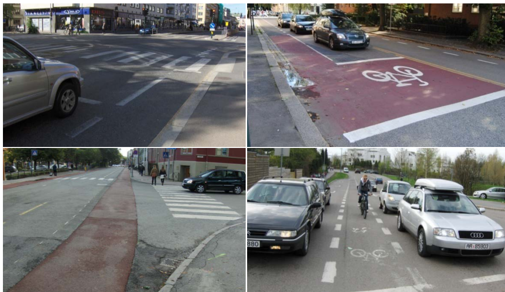
Figur 24. Eksempler på tilbaketrukket stopplinje, sykkelboks og midtstilt sykkelfelt signalkryss i Oslo og farget oppmerking i vikepliktsregulert kryss i Trondheim (Foto: M. Sørensen).
