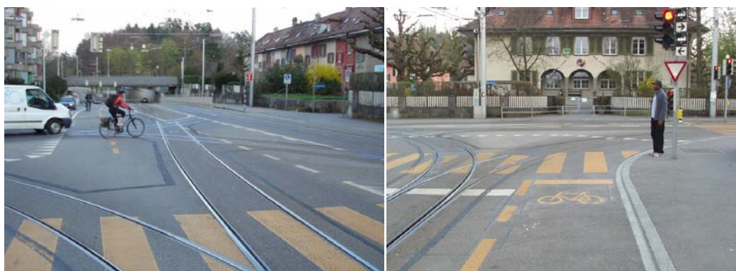
Figur 46. Trikkeskinner og oppmerking for syklende i kryss i Bern før og etter justering av oppmerkingen for de syklende (Pfeiffer 2013).
