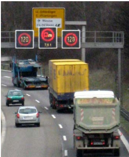
Figur 6.3: Variable fartsgrenseskilt med forbikjøringsforbud for tunge kjøretøy på veien B27 i Tyskland (EasyWay).
