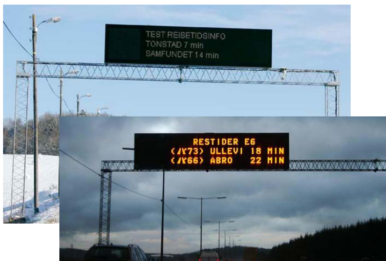
Figur 7.3: Eksempler på variable opplysningstavler med reisetidsinformasjon (Statens vegvesen, 2011; Vägverket, 2009A).
