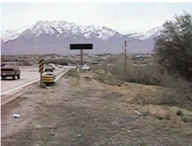
Figur 5.8: Variabelt skilt som kan vise tåkevarsling og anbefalt fart i tåke (Perrin et al., 2002).
