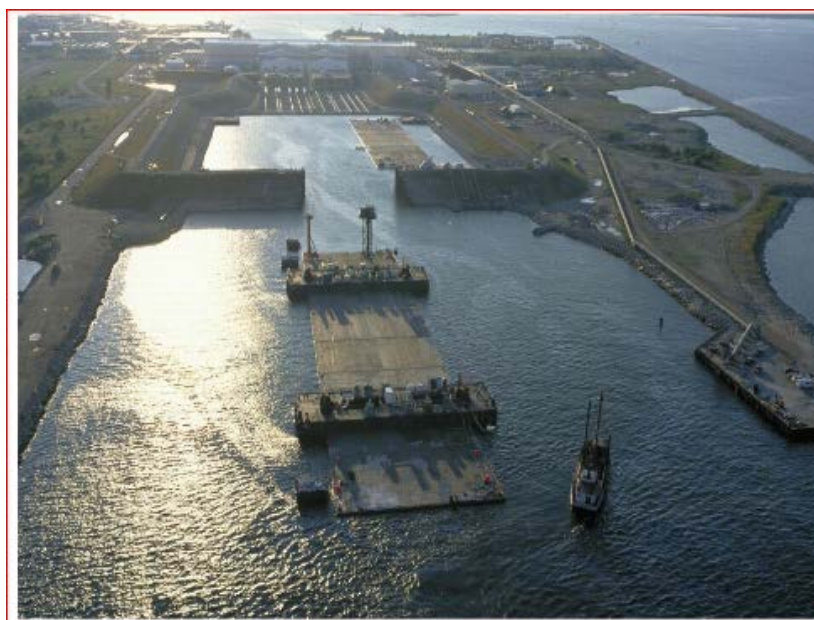
Figur 6.13: Flytedokker i Rødby, valgt konstruksjonsbase for tunnelmodulene. Foto: Green STRING konsortiet.
