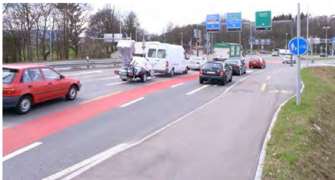
Figur 51: Valgmulighet mellom midtstilt sykkelfelt (best fremkommelighet) og separat løsning (større trygghet men mer forsinkelse) i Sveits. Foto: Foto: Velkonferenz Schweiz.
