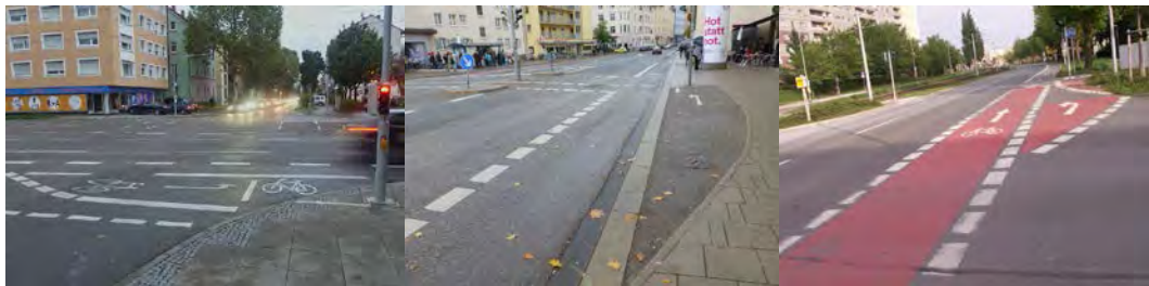
Figur 53: Sykkelsti med venstresvingfelt og egen venstresvingfase i signalregulert kryss. Foto: Radfabren in Stuttgart (t.h.); R. Erke. (midt); fahrrad3gruen.wordpress.com (t.v.).
