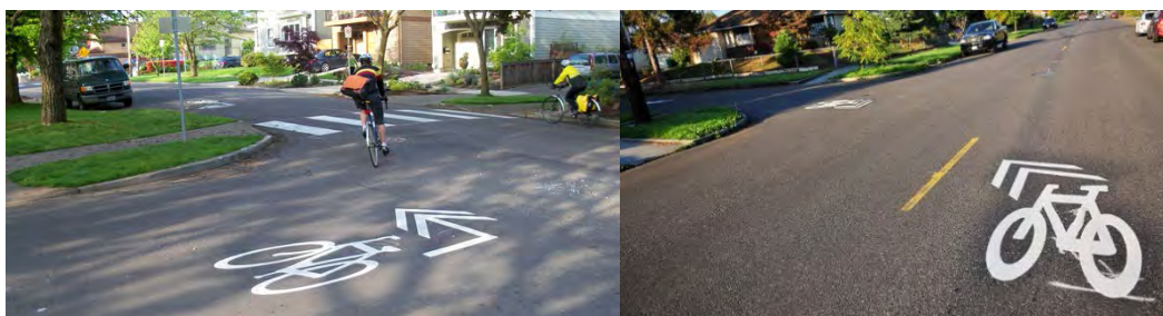
Figur 11: Eksempler på hvordan supplerende oppmerking av sersjant striper kan brukes som vegvisning langs sykkelrute. Foto: NACTO, 2014 (t.v.); Andersen, 2014 (t.h.).
