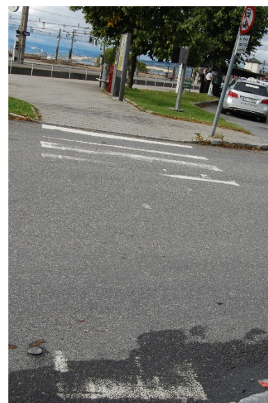
Slitte kontrastmerker på trappetrinnene og behov for vedlikehold av trapp til kulverten (t.v.) og slitt merking av fotgjengerovergang fra togstasjonen til busstasjonen (t.h.).
