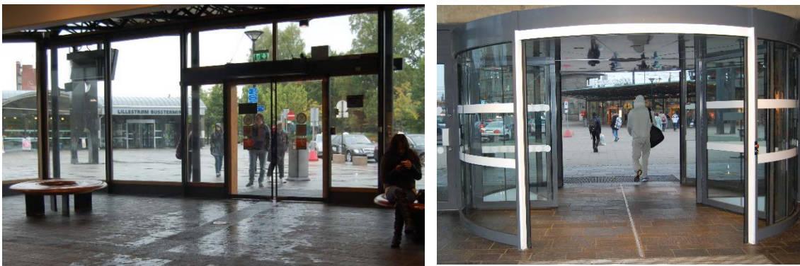
Hovedinngangen til togstasjonen har ingen kontraster på dørene (t.v.). Bussterminalen har klare kontraster ved hovedinngangen (t.h.).
