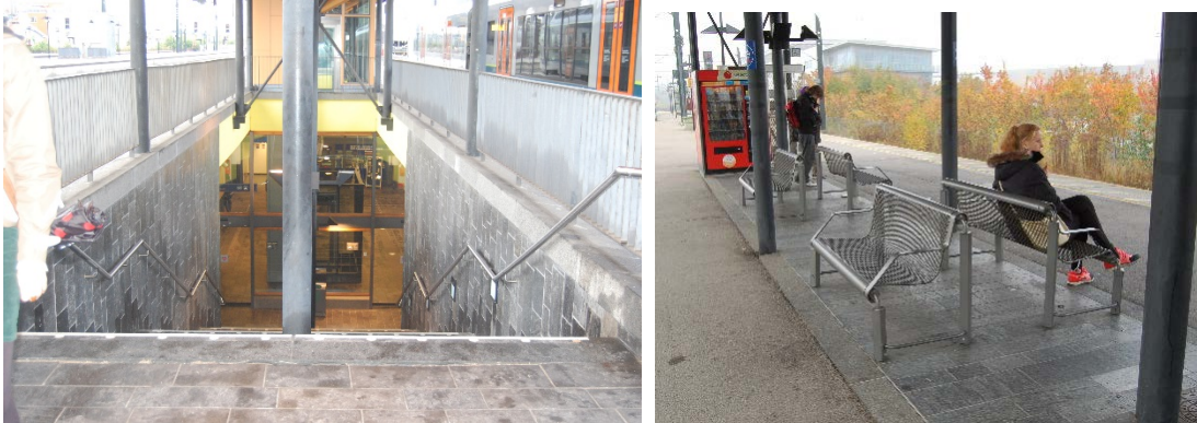
Trappen har gode kontraster og håndleder, men mangler farefelt som signaliserer hvor trappen er og starter (t.v.).
