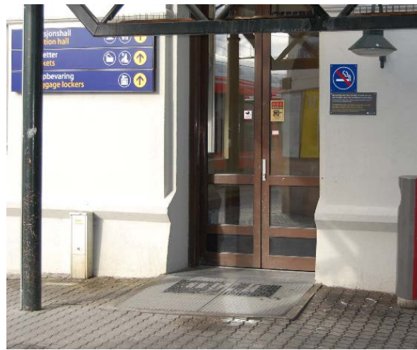
Hovedinngangen til stasjonsbygget er uten rekkverk eller kontrastlinjer (t.v.). Trinnfri sideinngang til stasjonsbygget (t.h.).
