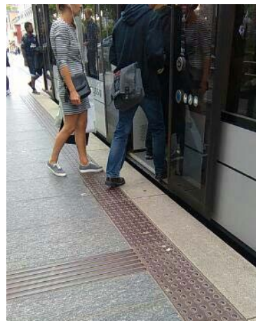
Figur 12: Eksempel på ledelinje som ikke leder til døren
