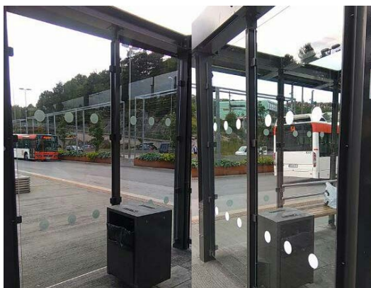
Figur 6: Det er viktig at markering av glass er like synlig på både utside og innside
