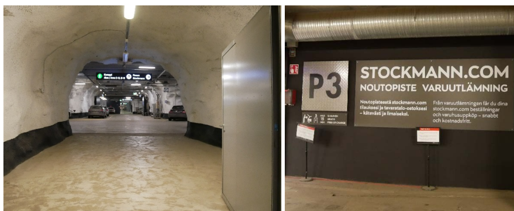
Figur 11: Det underjordisk parkeringsanlegget med heis og vareutlevering. Foto: Oddrun Helen Hagen.
