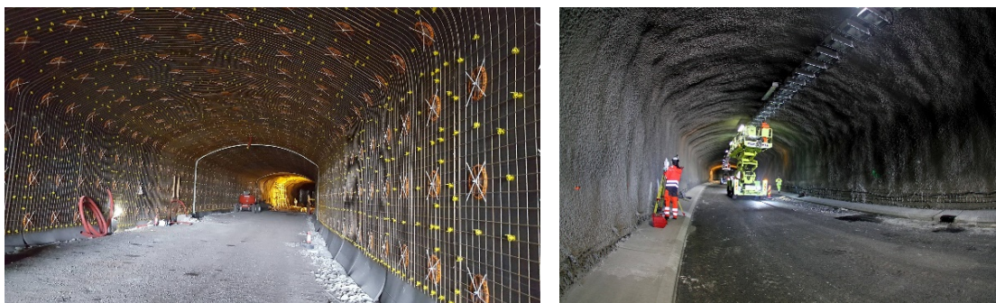
Figur 99: Rehabiliteringsarbeid i Brynstunnelen. Kilde: Statens vegvesen
