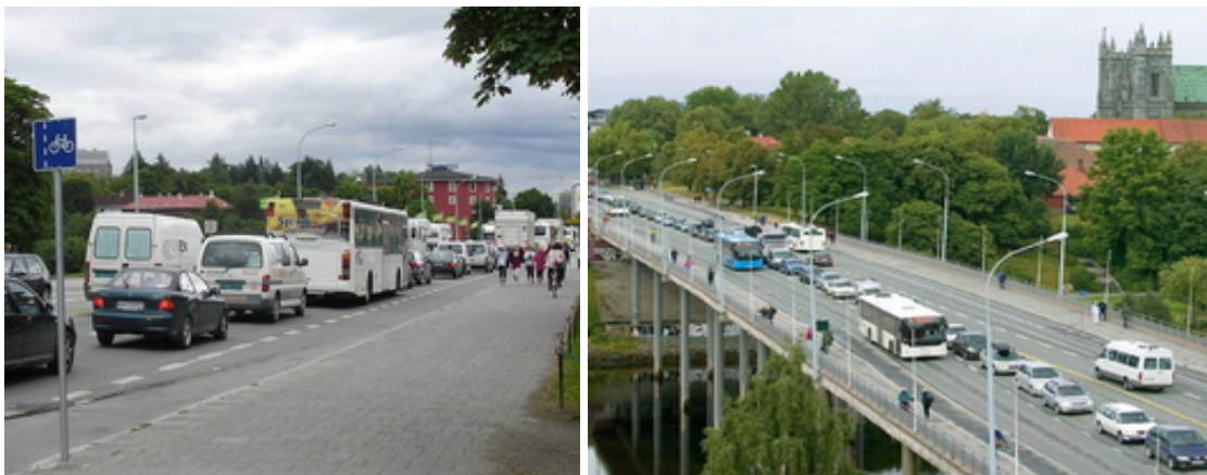
Figur 7: I 2008 ble ett felt i hver retning i Elgsetergate i Trondheim gjort om fra bil- til kollektivfelt. Foto til venstre viser forsituasjonen, der bussene står i kø sammen med bilene. Foto til venstre viser ettersituasjonen, hvor busstrafikken har fått økt fremkommelighet. Foto: Steinar Simonsen
