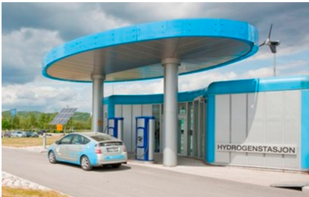
Figur 4.3: Hydrogenstasjon utenfor Porsgrunn (bilen er fra et Hynor-prosjekt med bensinmotorer og biler som ble modifisert til å bruke hydrogen som energibærer, bilde: internett)
