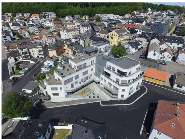
Figur 38: Sentralt lokalisert leilighetsbygg i Larvik. Foto: Roger Strøm i Inter Eiendom AS
