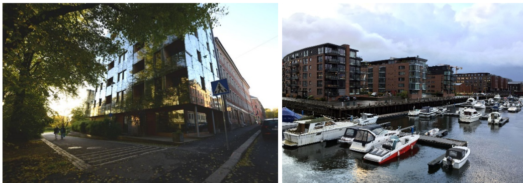
Figur 51: Til venstre vises infill-prosjektet Dalenenggata 36 i Oslo, som ble bygd på tidligere grøntareal som var regulert boligformål. Foto: Oddrun Helen Hagen. Til høyre nye boliger langs Nidelva i Trondheim, bygd på tidligere industriområder. Foto: Marianne Gjørn.
