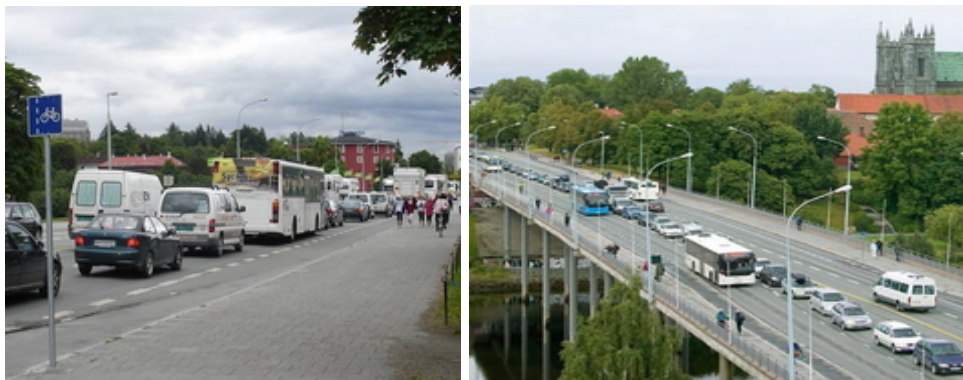
Figur 24: I 2008 ble ett felt i hver retning i Elgesetergate i Trondheim gjort om fra bil- til kollektivfelt. Foto til venstre viser forsituasjonen, der bussene står i kø sammen med bilene. Foto til høyre viser ettersituasjonen, hvor busstrafikken har fått økt fremkommelighet. Foto: Steinar Simonsen.
