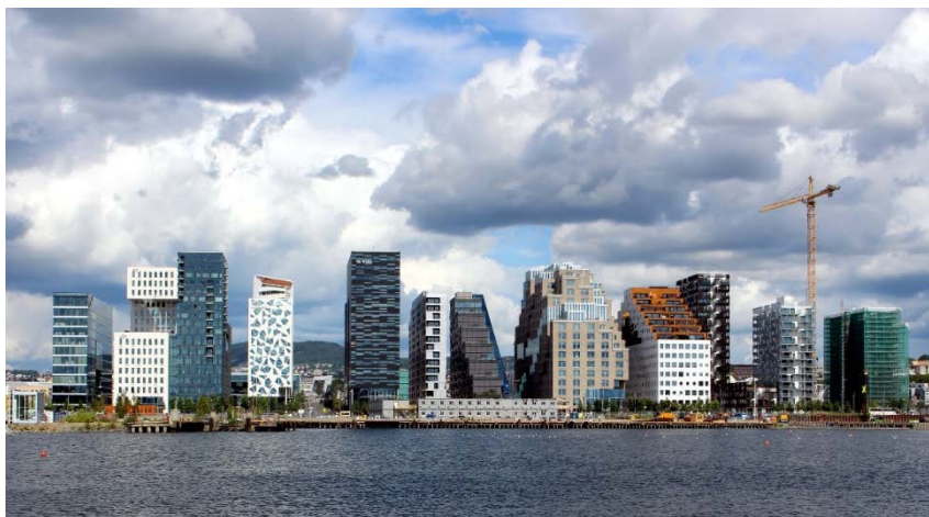
Figur 86: Barcode i Bjørvika i Oslo huser mange arbeidsplasser og ansatte som har god tilgjengelighet med andre transportmidler enn bil, og som kan bidra til mer liv og aktivitet i Oslo sentrum. Foto: Alexandra von Guttbenbach-Lindau, pixabay.com.
