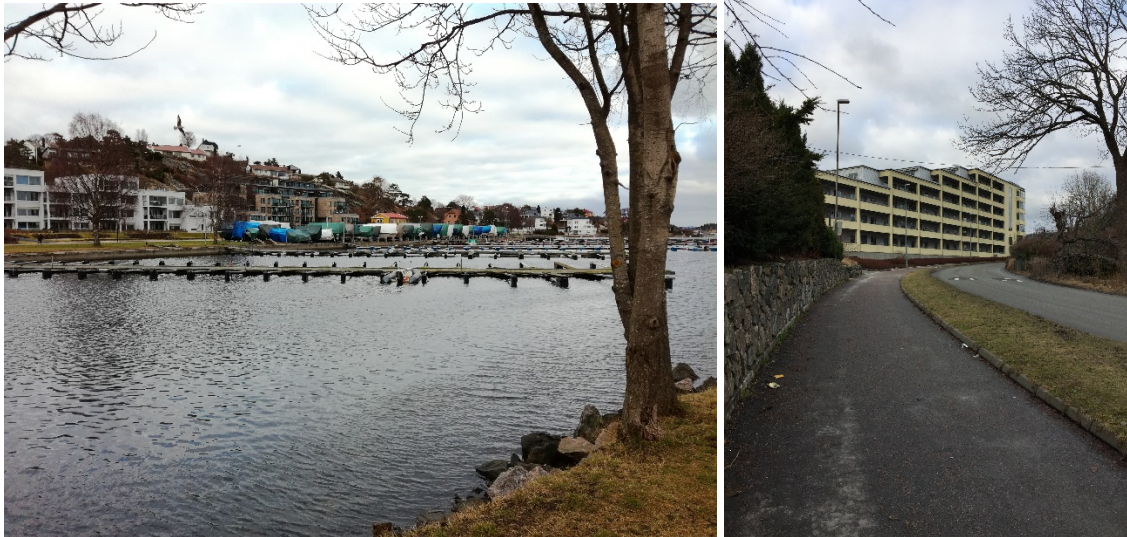
Figur 63: Småbåthavn og ny blokkebebyggelse ved sjøen til venstre. Gang-sykelsti og eldreboliger i Kirsten Flagstads vei til høyre. Foto: Oddrun Helen Hagen.
