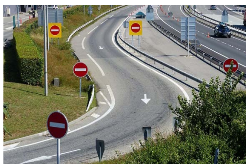
Figur 28. Traditionelle ”Indkørsel forbudt” skilte og ”Indkørsel forbudt” skilte på gul baggrund samt pilafmærkning på rampe i Frankrig (Wiki, 2016).
