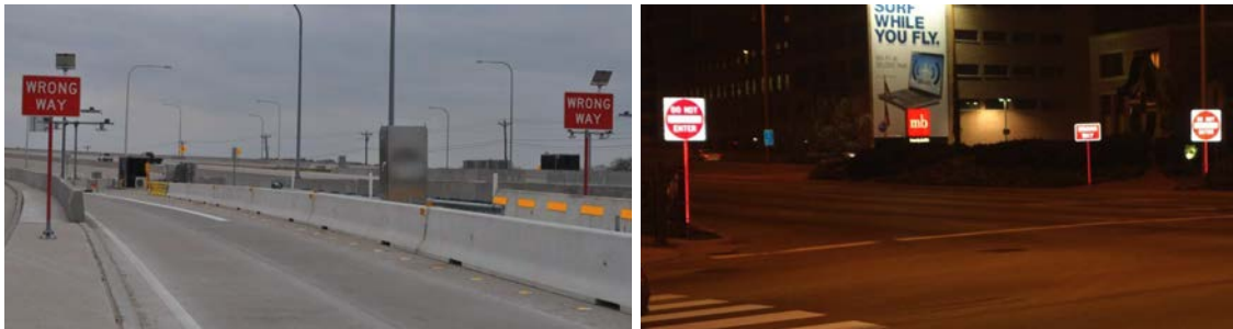
Figur 43. Skilt med rød reflekterende tape på skiltestang (Zhou og Pour-Rouholamin, 2014).
