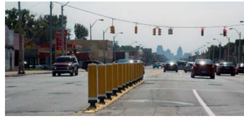
Figur 35. Kanalisering for at undgå forkert venstresving (Zhou og Pour-Rouholamin, 2014).
