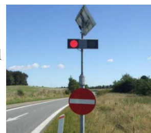
Figur 7. Spøgelseslys ved rampe (Blindum, 2011).
