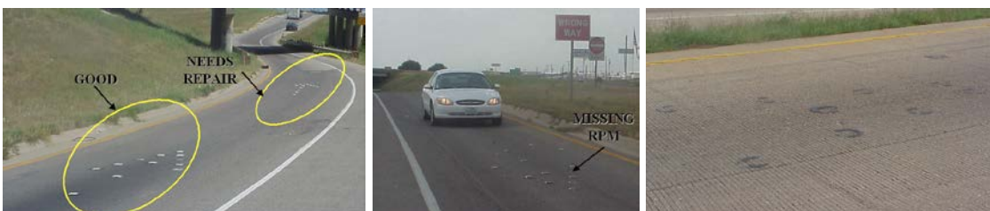
Figur 48. Mangelfuld vedligeholdelse af ophøjede købanereflektorer (Cooner, Cothron og Ranft, 2004b).
