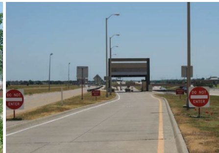
Figur 39. Brug af ”Do Not Enter” skilte i lavere højde (Zhou og Pour-Rouholamin, 2014).
