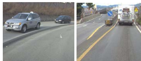
Figur 20. Opstart af autoværn i vejmidten på tosporet vej og fysisk adskillelse på dobbeltrettet rampe (Statens vegvesen, 2010).
