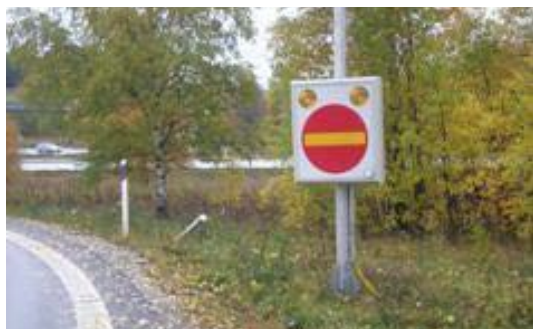
Figur 22. Gult blinkesignal sammen med "Indkørsel forbudt" skilt i Sverige (Statens vegvesen, 2010).
