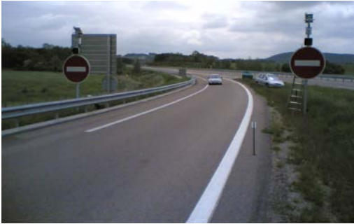
Figur 29. Videoovervågning på frakørselsrampe i Frankrig (Lansche, 2005).
