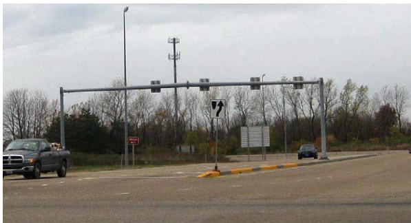
Figur 40. ”Keep Right” skilt i helleanlæg mellem til- og frakørselsrampe (Zhou og Pour-Rouholamin, 2014).
