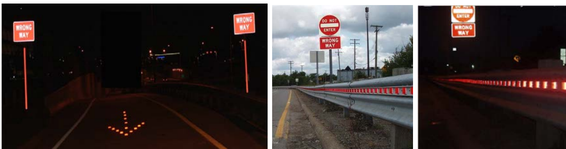
Figur 47. Reflektorer i købanen og i autoværn, som "lyser" rødt, når man kører i forkert retning (Zhou og Pour-Rouholamin, 2014).
