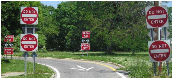
Figur 38. Dobbelt skiltning med ”Do Not Enter” og ”Wrong Way” på begge sider af frakørselsrampe samt supplerende pil på frakørselsrampen (NTSB, 2012).
