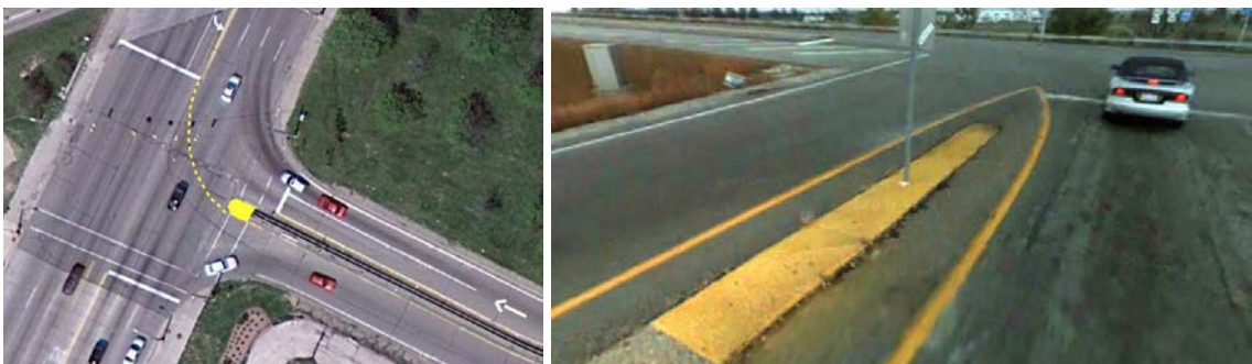
Figur 46. Afmærkning af spærreflade og linjer i rampekrydset, som hjælper trafikanterne til at foretage rigtigt venstresving (Zhou og Pour-Rouholamin, 2014).
