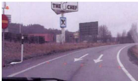
Figur 23. Rampe i Varberg med "Indkørsel forbudt" skilt med blinkende signaler samt LED-lys og opmærkede pile i vejbanen (Statens vegvesen, 2010).
