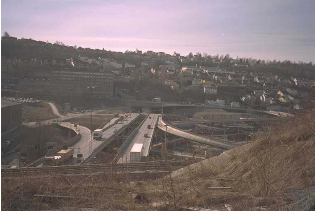
Trafikksystemet rundt munningen av Ekeberg tunnelen
