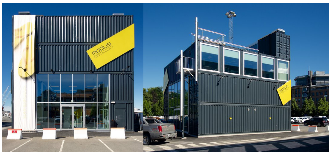
Figur 4.2: Containerstruktur lik den som er planlagt for Oslo City Hub. Kontorer tilhørende Modus Design AS på Filipstad i Oslo. Foto: Nils Petter Dale. Hentet fra: MMW.no
