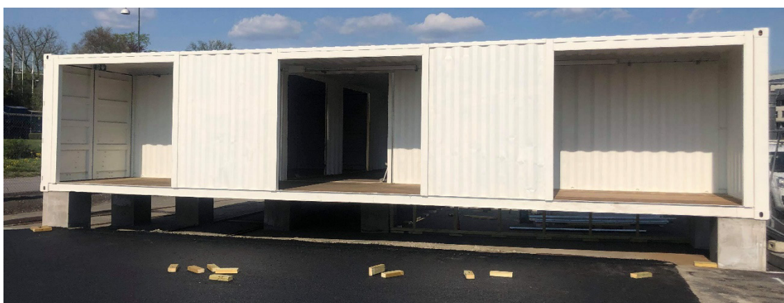
Figur 4.6: Byggeprosessen av Oslo City Hub tatt 29.april 2019. Foto: Tale Ørving
