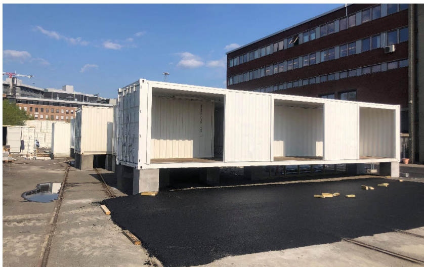
Figur 4.5: Byggeprosessen av Oslo City Hub tatt 29.april 2019. Mobn gården til høyre. Foto: Tale Ørving
