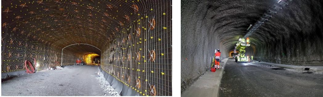
Figur 117: Rehabiliteringsarbeid i Brynstunnelen. Kilde: Statens vegvesen.
