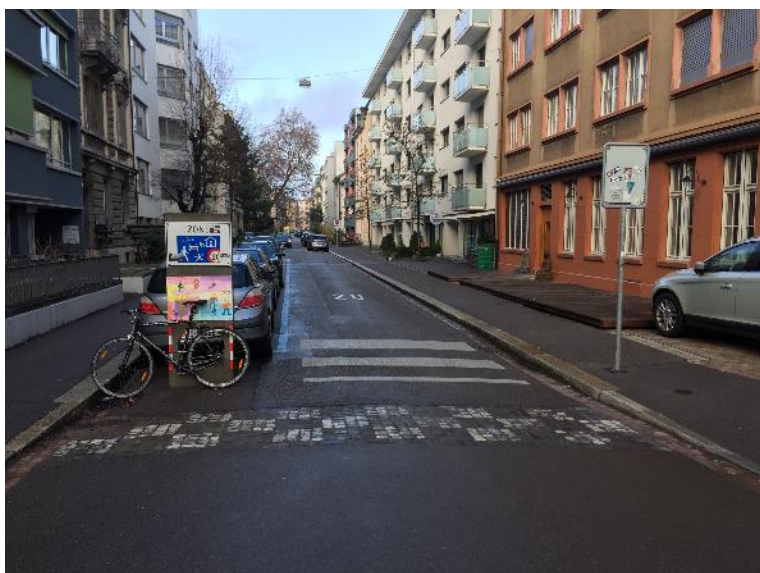
Figur 7: Utforming av inngang til en sone med fartshump i brostein. Denne sonen har all parkering på en side, noe kommunen helst vil unngå for å få ned kjørehastigheten. Foto: Maja Karoline Rynning.
