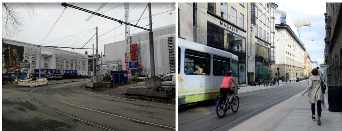
Figur 18: Til venstre: Midlertidig omlegging av trikk over Tullinløkka med tilhørende anleggsområde. Til høyre: Etter to års anleggsvirksomhet sto Prinsens gate ferdig oppgradert som trikkegate februar 2017. Foto: Oddrun Helen Hagen.
