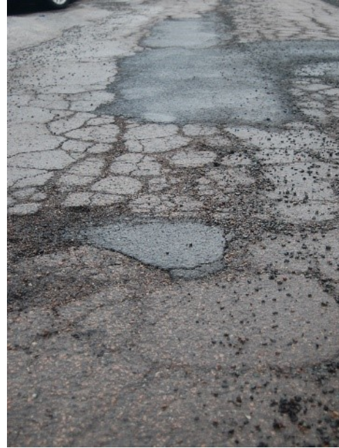
Figur 2: Bilde av sprukket og lappet dekke med grus for å belyse forhold vår/sommer/høst. Foto: Torkel Bjørnskau.
