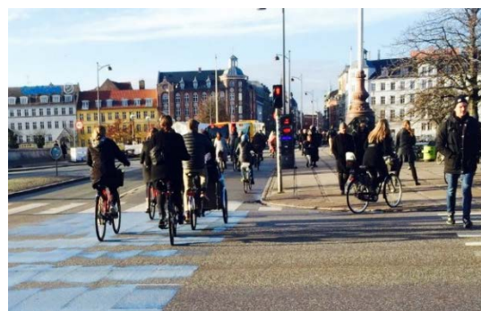
Figur 2: Dansk cykelsti, som i kryss rampes ned og blir på same nivå som vegbanen.
