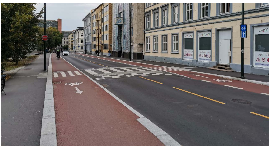
Figur 8: Åkebergveien foran Oslo fengsel etter utbygging.
