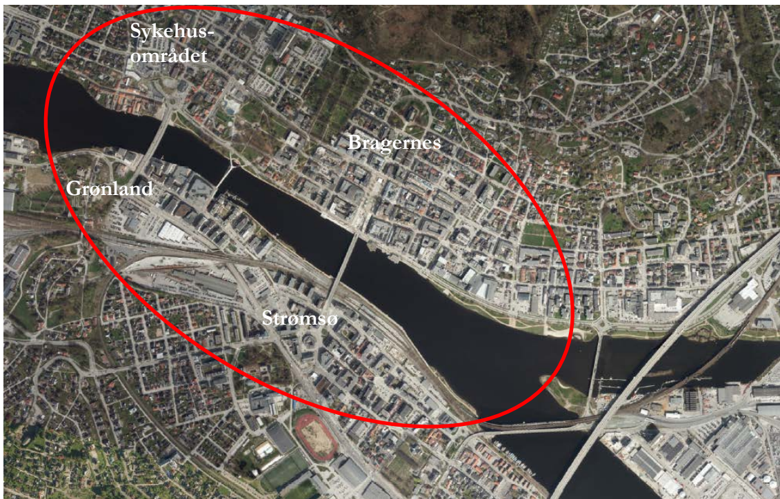
Figur 6: Luftfoto av Drammen sentrum. Luftfoto: ©kartverket/norgeidag. Kjerneområdet for leveranser fra samleterminalen er omtrentlig markert med rød strek.
