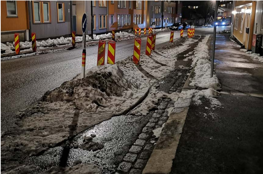
Figur 11 Eksempel på manglende snøbrøyting bak barrieren i Strømsveien.
