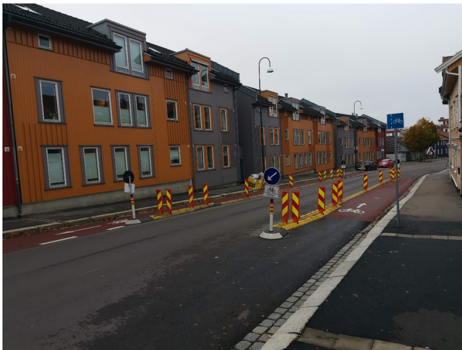
Figur 8 Strekningen med Klemmfix i Strømsveien.
