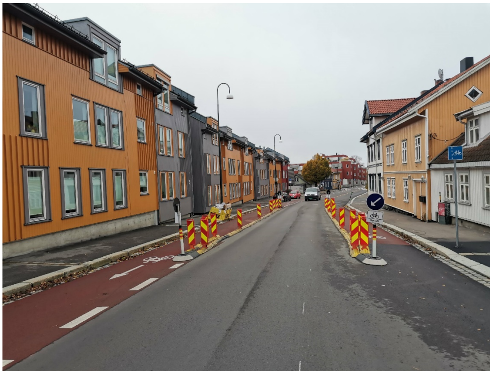
Figur 9 Strekningen med Klemmfix i Strømsveien.
