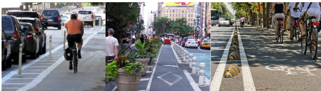
Figur 4: Eksempler på ulike varianter av beskyttet sykkelfelt fra Chicago, New York og ukjent by. Foto: Pundit, 2012 (t.v.); Cirrus, 2009 (midt); Delaware, 2014 (t.h.). Fra (Høye, Sørensen, & de Jong, 2015)
