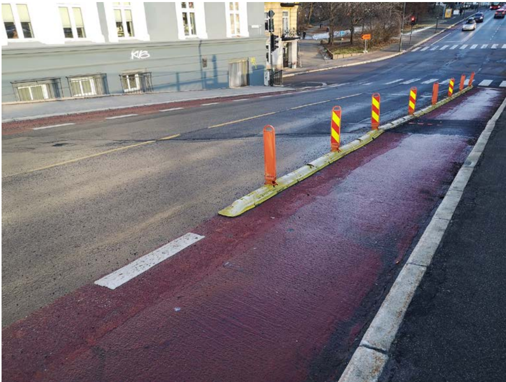
Figur 7 Strekningen med Klemmfix i St Halvards gate.
