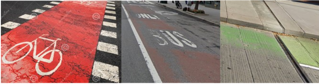
Figur 8: Sykkel- og kollektivfelt med eldre maling; fra venstre til høyre: Dreamstime.com (ukjent sted); Google Maps (3rd Ave, Manhattan, New York), Google Maps (2775 South St, Philadelphia, Pennsylvania).
