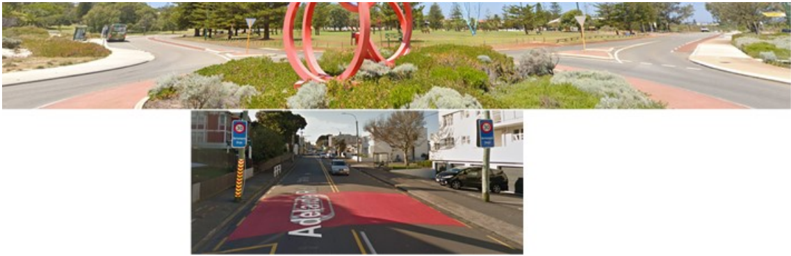
Figur 2: Andre bruksområder for rødt dekke i Australia (rød midtdeler, øverste bilde, med røde sykkelfelt t.b. i bildet) og New Zealand (varsling om lav fartsgrense, nederste bilde).
