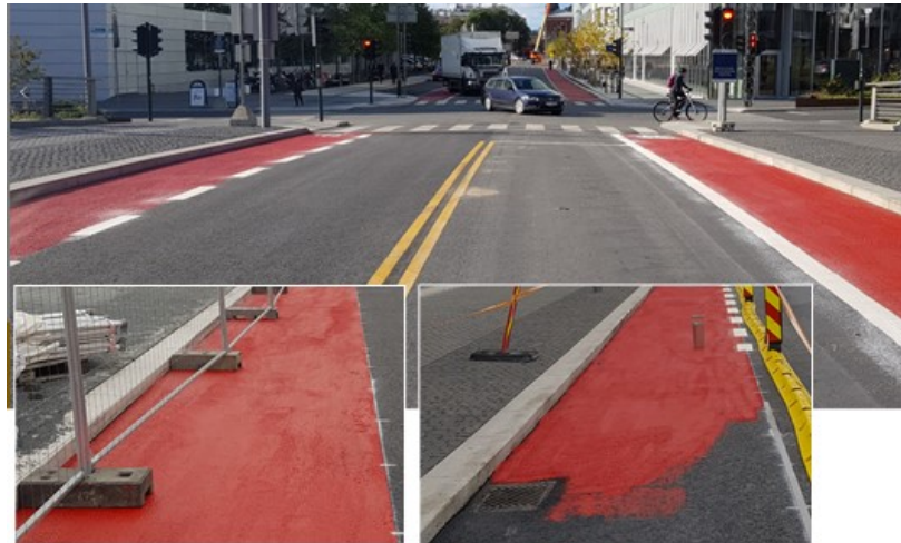
Figur 9: Nylagt MMA på Dronning Eufhemias gate i Oslo ( https://a-merking.no/sykelkelfelt/ ).
