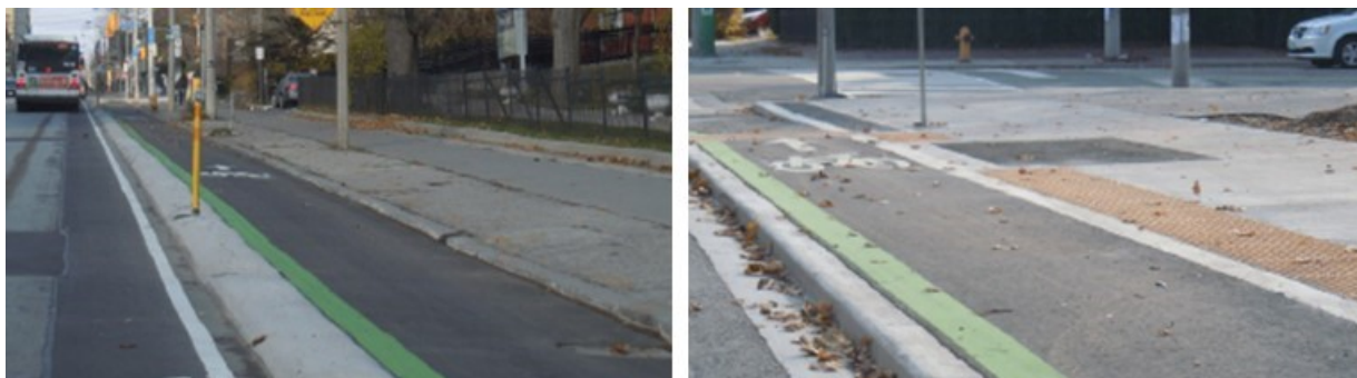
Figur 23: Sykkelekspressveg med farget kantlinje i Canada (Ontario Traffic Manual – Book 18, .
