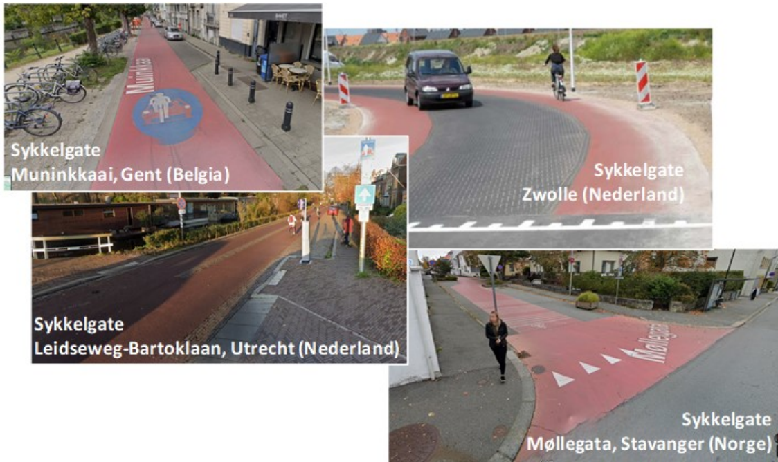
Figur 21: Eksempler på sykkelgater med farget dekke (bilder: Google maps / øverst t.h.: Furth, 2010).
