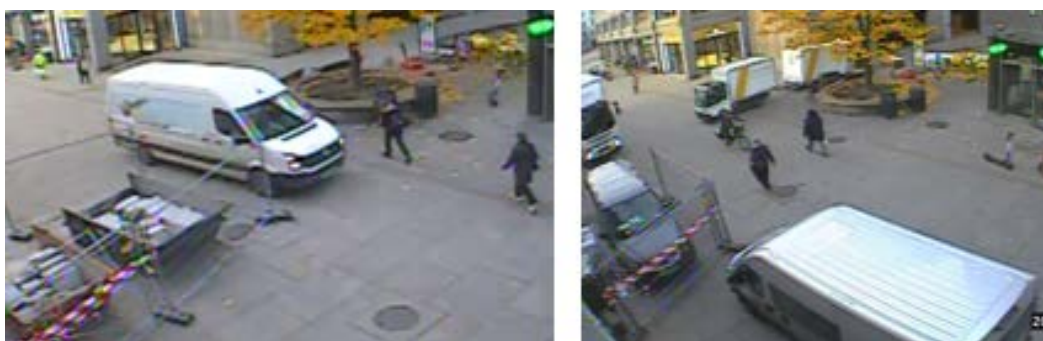
Figur 2.6: Begrenset plass på grunn av byggeplassen og parkerte biler.
