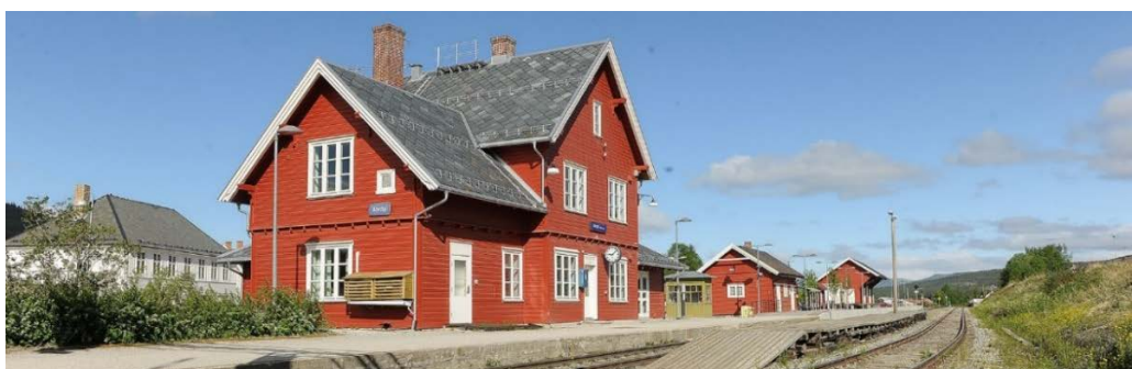
Figur 4.41: Stasjonsbygningen i Lille-Elvedal stasjonsby (Foto: Klara Skovro Thoresen. Kilde: https://www.opplevalvdal.no/attraksjoner/steia ).
