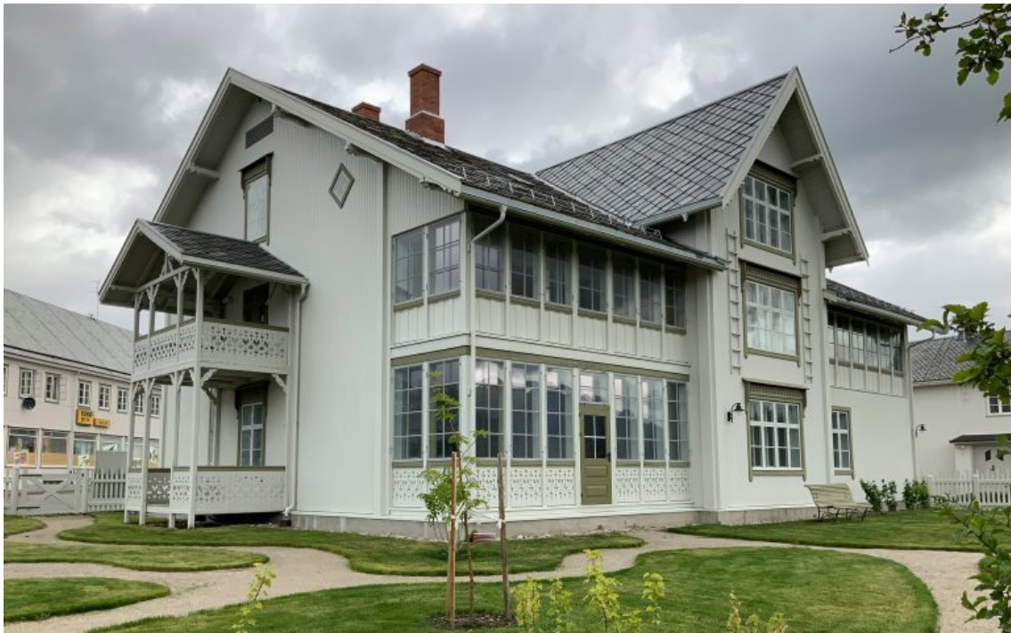
Figur 4.42: Steien hotell som ble restaurert som følge av Steiaprosjektet (Foto: Steien hotell. Kilde: https://www.steienhotell.no ).
