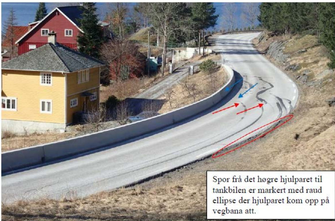
Figur 10: Biletet viser kurva og spora som blei avsette der ulukka hende, sett i køyreretninga til tankbilen. Dei raude pilene viser spor etter tankbilen. Dei blå pilene viser sporavsetjing/merke etter personbilen. Foto/illustrasjon: SHT
