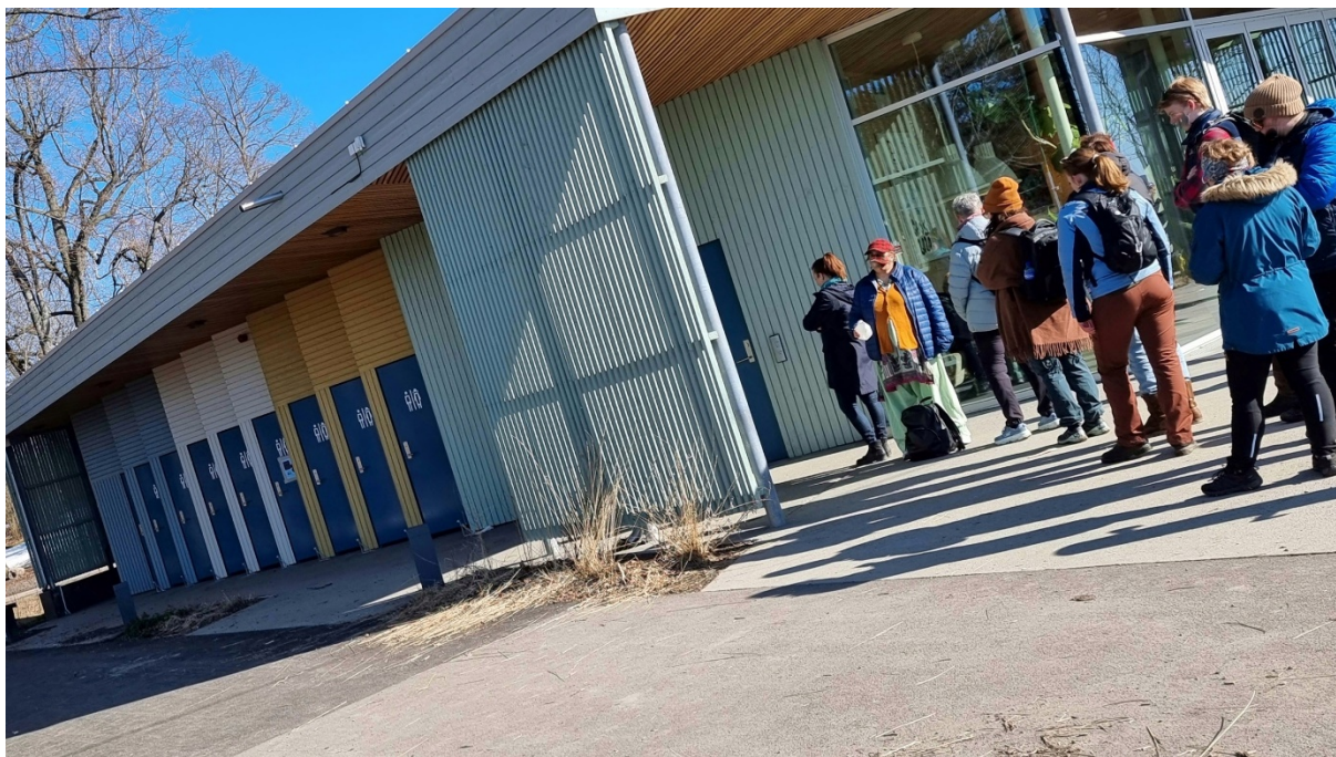
Figur 3.2: Bildet viser toalettfasiliteter på Bygdøy strand. Her er det rikelig med toaletter, men siden bare et av toalettene er åpnet på vinterstid, er køen lang.
